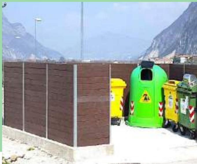
Mascheramenti con sistemi di fissaggio zincati a caldo.
